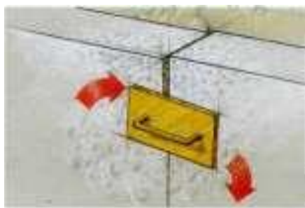
Рис. 7 - Выравнивание (стесывание) неровностей плит
