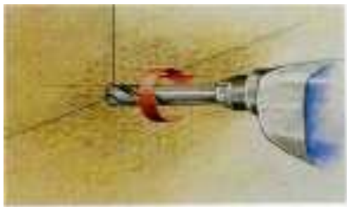
Рис. 15 - Сверление отверстий электродрелью
