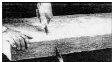
Рис. 5 - Подрезка теплоизоляционных плит ножом
