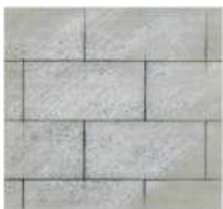
Рис. 8 - Перевязка рядовых плит
