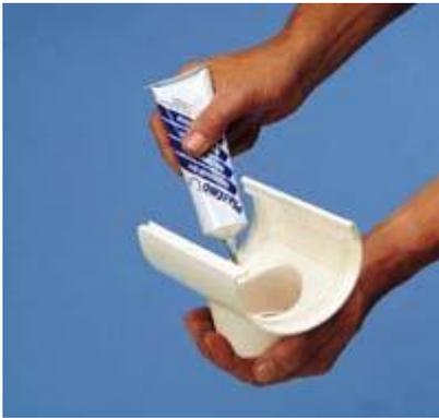
**11.** По внутренней части периметра воронки нанесите полоску клея шириной около 5 мм, отступив 10 мм от краев. Нанесите еще по 2 полоски клея по краям отверстия. Сборку начинайте немедленно.
