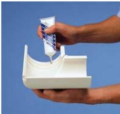
**16.** На внутреннюю часть одной половины уголка нанесите две полоски клея шириной около 5 мм.
