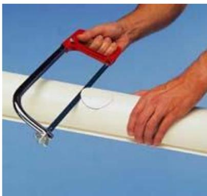
**10.** Мелкозубчатым полотном ножовки произведите два косых запила напротив друг друга. Зачистите края распилов.
