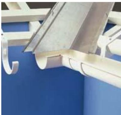
**17.** Желоб с приклеенным уголком устанавливают в кронштейнах. Далее клей наносят на вторую внутреннюю часть уголка и следующий желоб соединяют с уголком.
