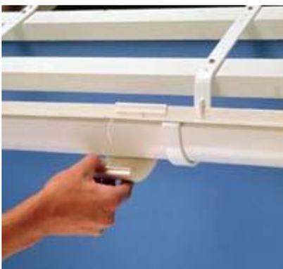
**15.** Немедленно зацепите кромку соединительного элемента за задний край желоба, а затем заведите переднюю кромку элемента за передний край желоба.
