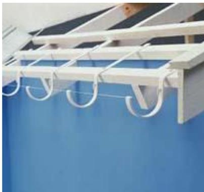
3. Оба крайних кронштейна устанавливаются на расстоянии около 150 мм от краев крыши. Далее натяните шпагат между наружными концами этих кронштейнов. Остальные кронштейны устанавливаются с шагом около 600 мм и крепятся гвоздями с гальваническим покрытием.
