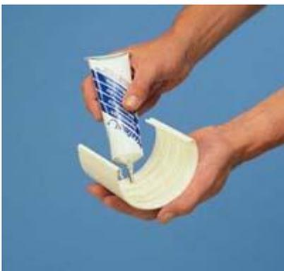
**14.** При соединении желоба необходимо следить за плотной стыковкой их концов. Затем на внутреннюю часть соединительного элемента наносятся 4 полоски состава «холодной сварки» шириной 5 мм, отступив примерно 15 мм от краев.
